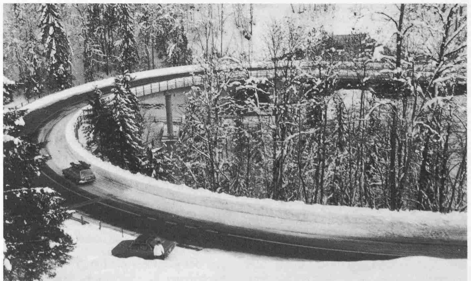
Bild 2. Brückenansicht von Seite Habkern
