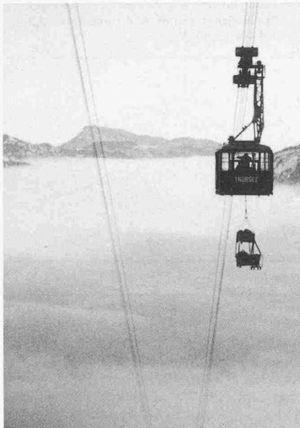
Bild 11. Antransport des Spannmaterials mit der Seilbahnkabine
