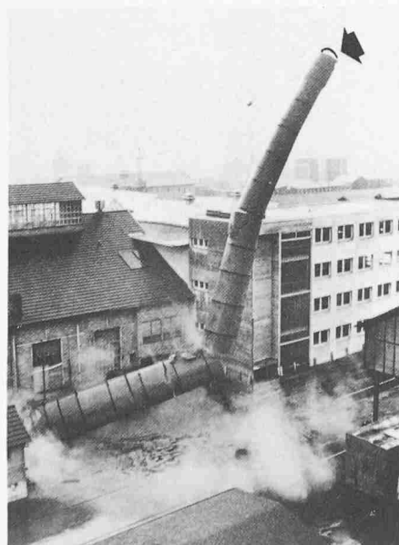
Bild 6. Wegschleudern des Gussrings
