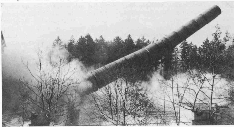
Bild 2. ... aber erst jetzt – in bald horizontaler Lage – treten Risse auf. Sie sind jedoch senkrecht zur Kaminlängsachse und nicht schräg dazu, wie das in der Regel der Fall ist (Badener Tagblatt)
