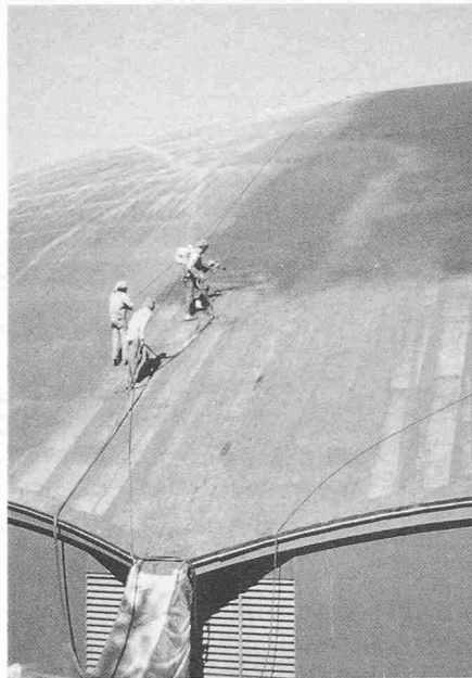
Bild 6. Abdichten der Dachhaut
