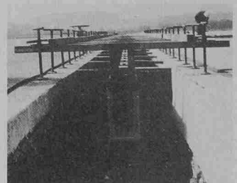
Rinne versetzt, vor dem Betonieren
