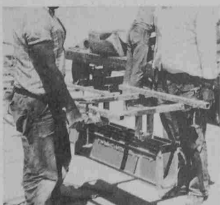
2 Mann tragen Polydrain mit Versetz-einrichtung
