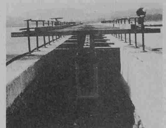
Rinne versetzt, vor dem Betonieren
