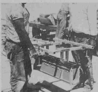
2 Mann tragen Polydrain mit Versetz-einrichtung
