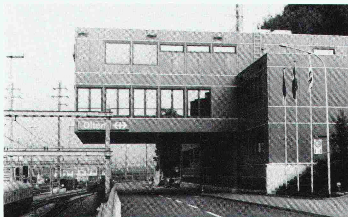
Neues Stellwerk Bahnhof SBB, Olten, Fahrbahnisolierung
