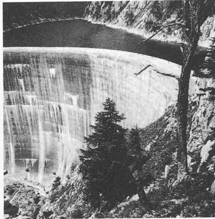
Bild 5. Salzsperre, Österreich (aus «Die Talsperren Österreichs», Heft 24 des ÖWWV)
