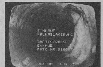
Auf dem Monitor werden Messwerte wie Distanz, Längsgefälle und Querverneigung im Fernsehbild festgehalten
