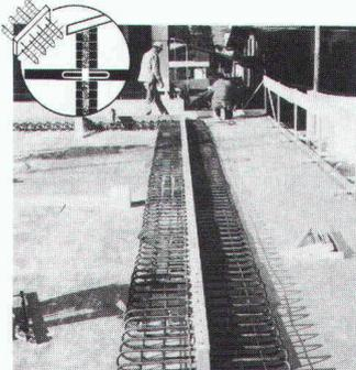
**Egco - wärmedämmender Kragplattenanschluss, stützenfrei**
