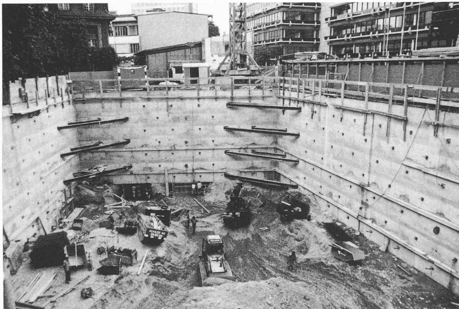
Bild 1. Baugrube für den Neubau der Banque de Paris et des Pays-Bas (Suisse) S.A., Basel. Ansicht Richtung Neubau der SBV. Deutlich erkennbar das feinmaschige Netz der horizontalen und vertikalen Arbeitsfugen sowie die Ankerplatten und Ecksprisse.
