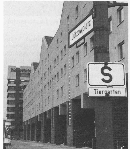
Lützowplatz West, Strassenfront
