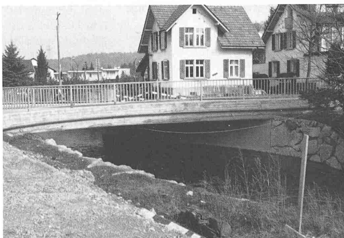
Bild 2. Neue Wynabrücke Vorstadt, Gränichen. Ansicht
