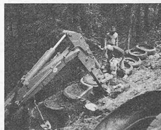
Bild 1. Begrünbare Böschungsbewehrung aus Altreifen
