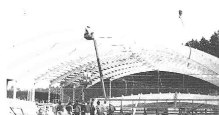
9119 Langenthal 1982-84 Überdachung Kunsteisbahn, Ing. Duppen-thaler + Wälchli
