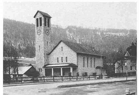
5210 Villeret 1961 Chapelle catholique, Arch. Bueche Jeanne
