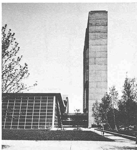
6043 Biel 1961-66 Kongresshaus und Hallenbad, Zentralstrasse 60, Arch. Schlup Max, Mitarb. Scacsigini M., Studer E.
