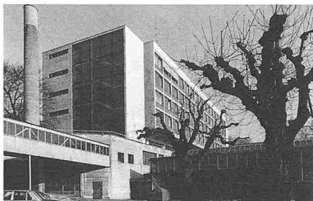
3090 Bern 5 Lorraine 1937-39 Gewerbeschule und Erweiterung Lehrwerkstätten, Lorrainestrasse 1, Arch. Brechbühler Hans, Wettbewerf
