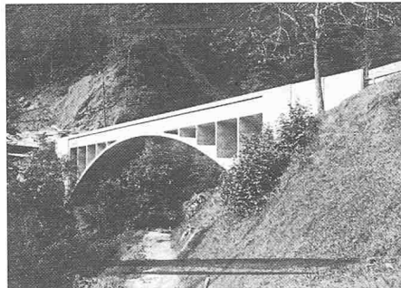
0120 Habkern 1932 Traubachbrücke, 500 m oberhalb Dorfkern Richtung Schwendi, Ing. Maillart Robert
