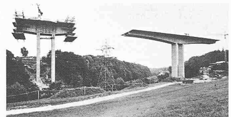
3162 Bern 2, Felsenau 1971-74 N1-Felsenaubrücke, 1116 m lang, Hauptspannweite 144 m im Freivorbau, Ing.gem. Prof. Ch. Menn und Emch + Berger AG
