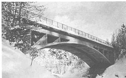
0190 Adelboden 1930 Spitalbrücke, 3 km unterhalb Adelboden (Kantonsstrasse), Ing. Maillart Robert, Publ. Bauzeitung April 1938
