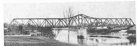
4311 Brügg 1928/1965 Eisenbahnbrücke, 1928 Ing. Wolf & Co., 1965 Losinger AG, Wartmann AG
