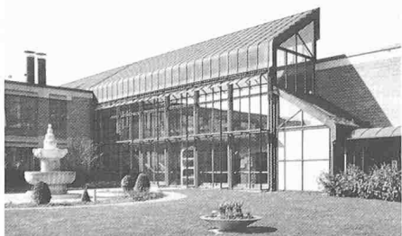
8127 Burgdorf Schlossmatt 1976-78 Alterspflegeheim Burgdorf, Einschlagweg, Arch.gem. Indermühle AG, Keckeis Adrian, Publ. Burgdorfer Tagblatt 7/78
