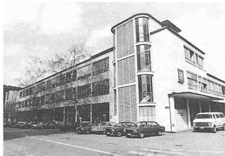
6029 Biel 1935 General Motors, Montagehalle, Salzstrasse 21, Arch. Städt. Hochbauamt und Dr. h. c. Rudolf Steiger
