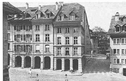
3145 Bern Altstadt 1963-64 Altstadtreparatur, Gerechtigkeitgasse 12+14, Arch. Haltmeyer Hans
