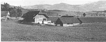
0240 Reutigen 1980/81 Kant. Fischzuchtanstalt, Arch. Baeriswyl Pierre
