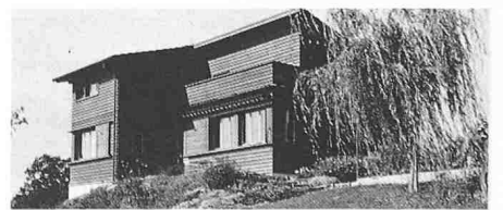
2100 Bolligen 1934 Einfamilienhaus, Arch. Jenny M.
