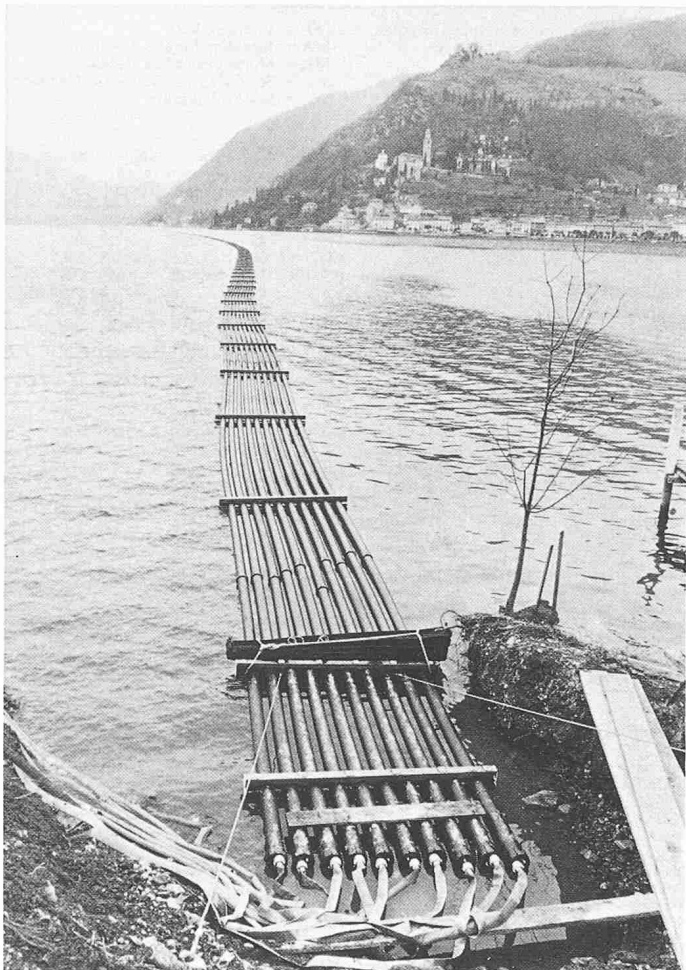
Bild 2. Die flexiblen Polyethylen-Rohrstränge verlassen das Werk Subingen der Von Roll AG
