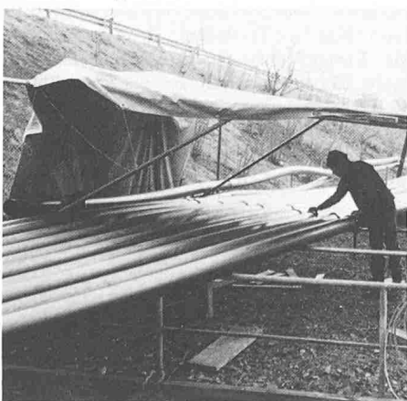
Bild 3. Verschweissen der Rohrstücke mittels Elektroschweissmuffen in Melide
