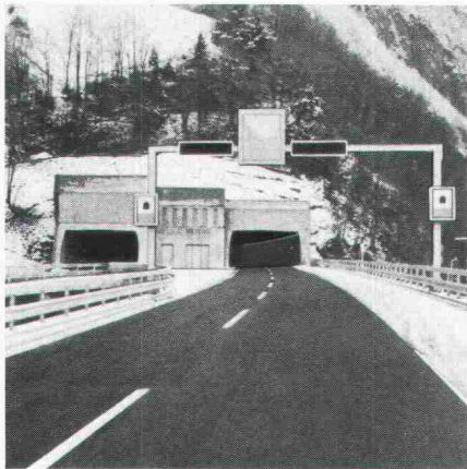
... wo Strassentunnels sicher sein müssen
