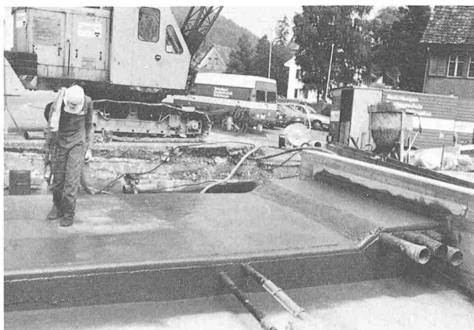
Bild 1. Brückenabdichtung (Bachdurchlass in Turbenthal): Nicht nur Auf- und Abbordungen, sondern eng nebeneinander liegende Rohrdurchführungen können im Vatec-Spritzverfahren problemlos abgedichtet werden. Die Schubkräfte werden dank dem vollflächig haftenden und kraftschlüssigen Verbund der Abdichtung mit dem Beton auf die Tragkonstruktion übertragen.
