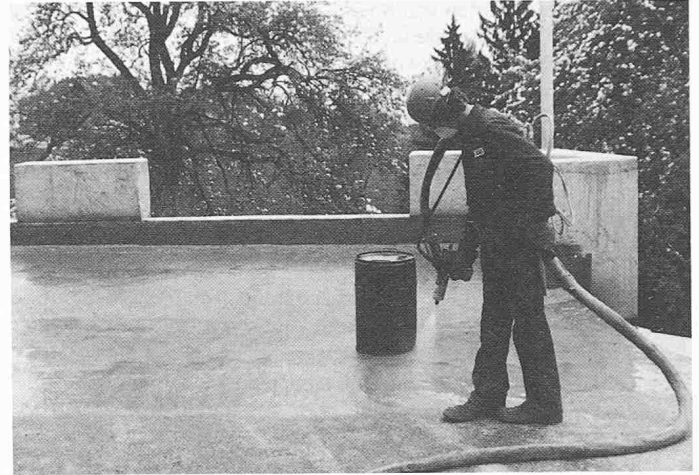
Bild 4 Terrassen-Abdichtung Wald/ZH: Die nahtlose Spritzapplikation gewährleistet eine einwandfreie sowie riss- und fugenüberbrückende Abdichtung.
