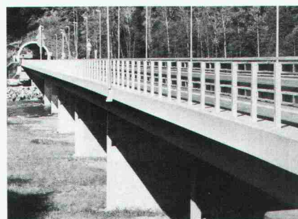
Autobahnbrücke Als frost- und tausalzbeständige Beschichtung
