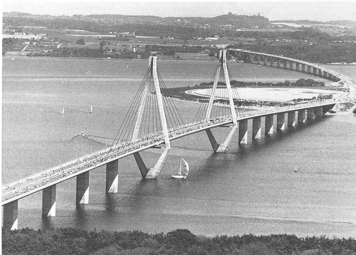
Bild 3. Die Schrägkabelbrücke Farø-Falster
