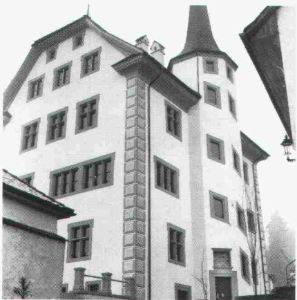
... wo historische Bauten gefährdet sind
