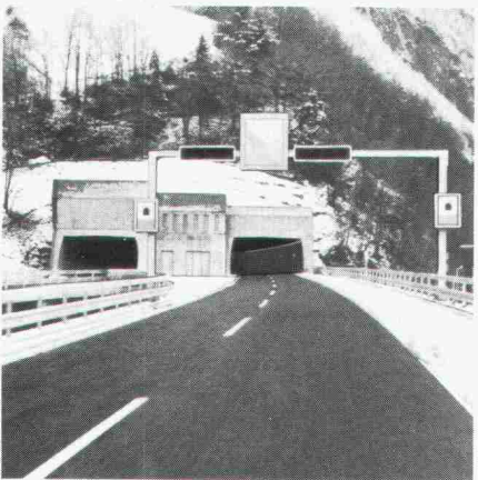
... wo Strassentunnels sicher sein müssen
