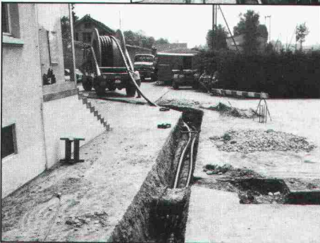
FLEXWELL-Leitungen von der Rolle in den Graben
