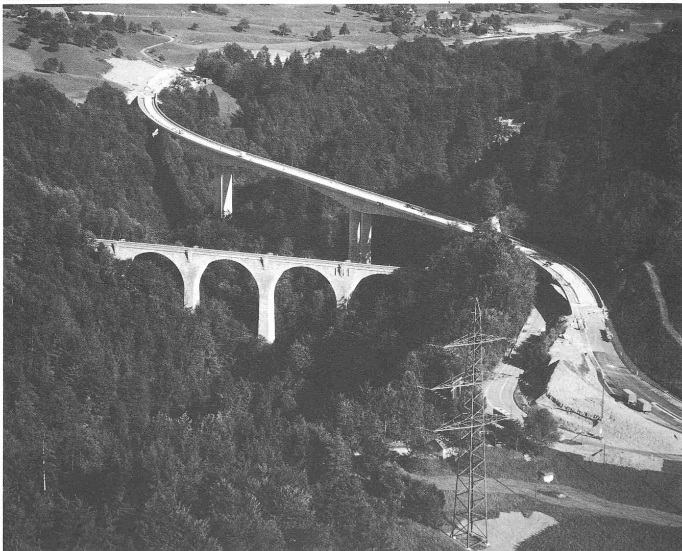
Alte und neue Lorzentobelbrücke
