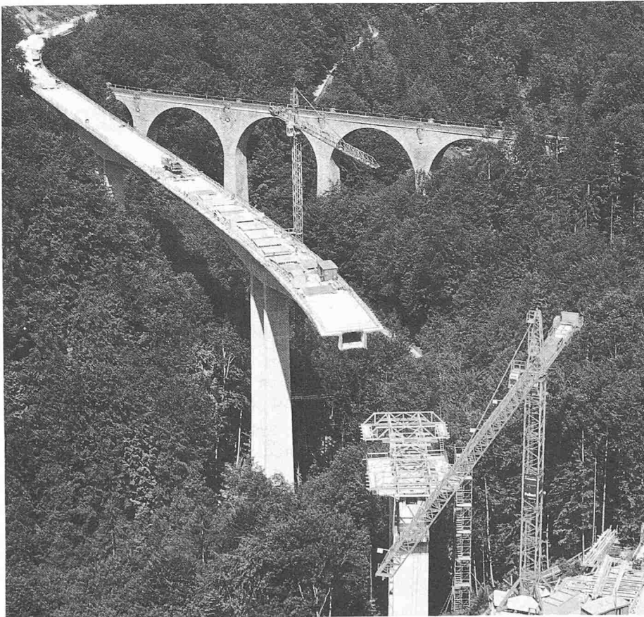
Bauzustand Freivorbau S3 und S4, Herbst 1984
