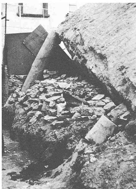
Bild 23. Beim Kippen des Gebäudes (Bild 22) wurden die Pfähle auf der einen Seite aus dem Boden herausgezogen
