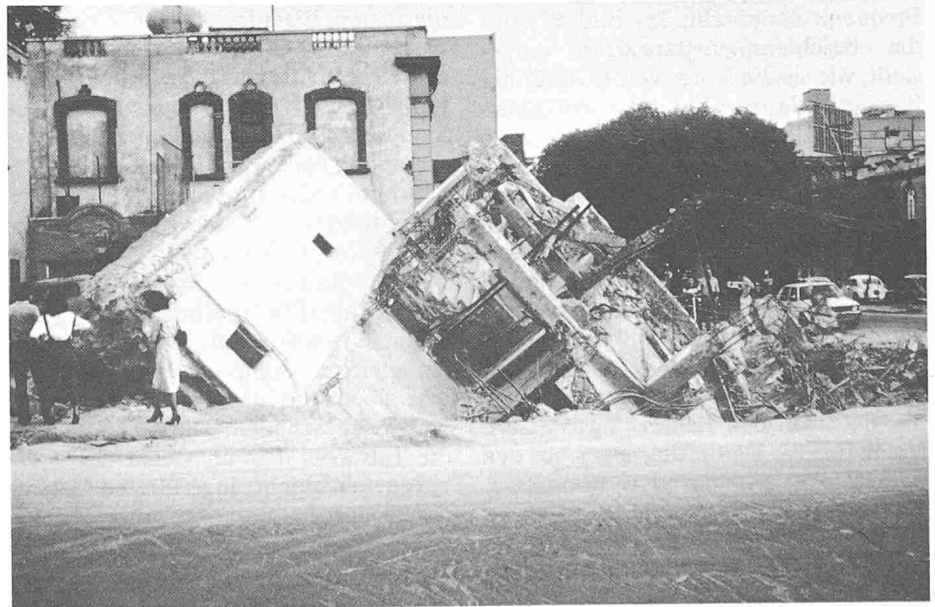
Bild 22. Dieses Gebäude kippte infolge Versagens der Reibungspfähle
