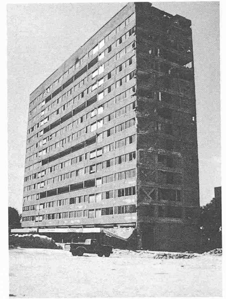
Bild 13. Stahlbetonskelett-Gebäude mit Aussteifungen mittels Stahlbetondiagonalen (ein analoges, direkt anschliessendes Gebäude stürzte ein, vgl. Bild 1a, Tlatelolco-Bezirk)
