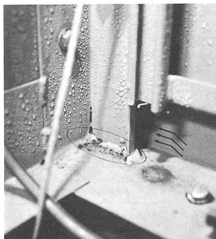
Bild 6. Kondenswasserbildung und Verschimmelung im Fussrahmen eines Apparateschranks
