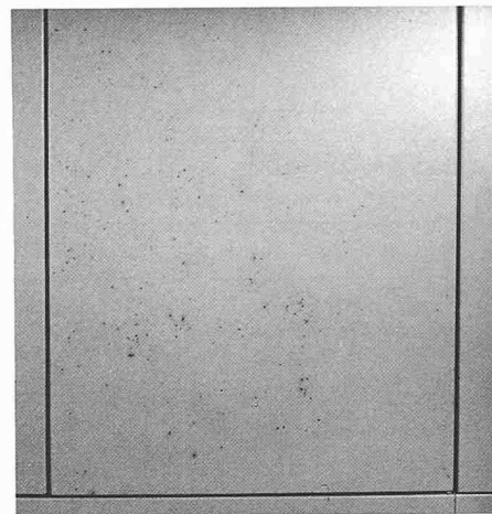
Bild 10. Punktuelle Durchrostung
