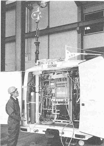
len sowie über ein Wetterdaten-Erfassungssystem. Je nach Problemstellung lassen sich weitere Geräte lose mitführen. Sie können an das dafür vorgesehene Bord-Messgasverteilnetz angeschlossen werden. Des Weiteren werden Stahlflaschen mit Eich-, Brenn- und Nullgasen mitgeführt.
