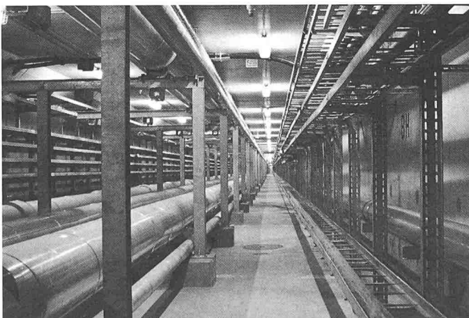
Bild 1. Begehbarer Leitungstunnel
