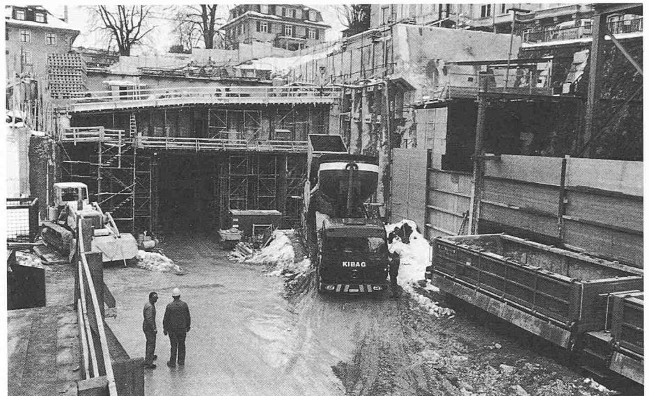
Bild 2. Tunnel Rämistrasse. Baugrube am Tunneleingang
