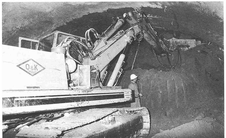
Bild 3. Tunnel Rämistrasse. Ausbruch unter dem Gefrierkörper
