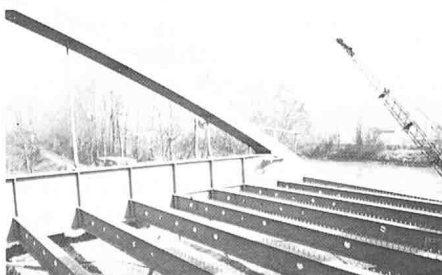
Bild 2. Montage der Aufhängungen und Querträger
