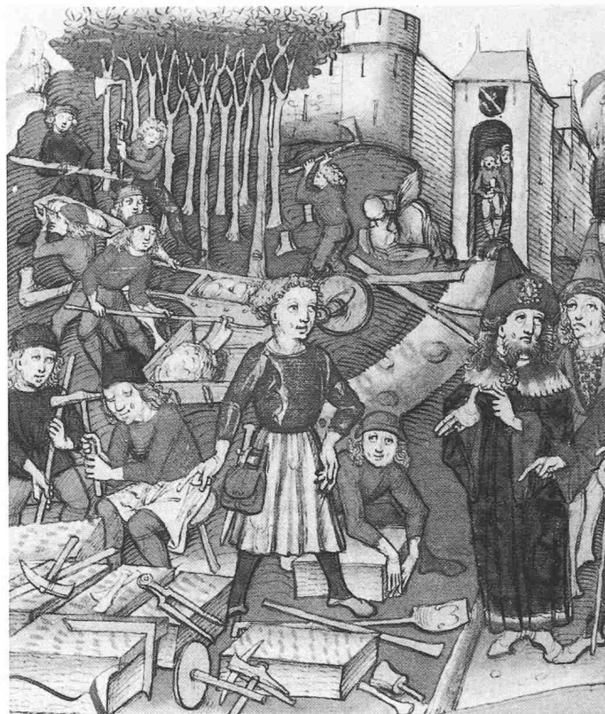
Mittelalterliche Baustelle. Zu erkennen sind folgende Arbeitsvorgänge: Steinmetzarbeiten und die dazugehörigen Werkzeuge, Mischen und Abtransport des Mörtels sowie das Schlagen von Bauholz. Beide Abbildungen stammen aus der Spiezer Chronik des Diebold Schilling
