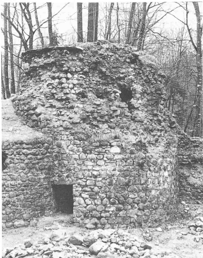
Wildenburg ZG. Der Rundturm der Ruine vor der Konservierung
