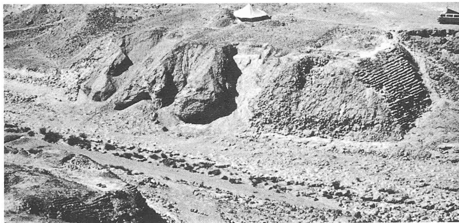
Bild 3. Wasserseitige Ansicht der Überreste des Dammes Kafara 30 km südlich von Kairo mit seiner sorgfältigen Steinabdeckung (Foto H. Fahlbusch, Ratzeburg/BRD)
