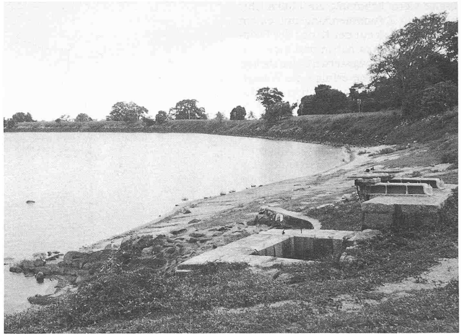
Bild 13. Wasserseitige Ansicht des Erddammes Nuwara mit Schacht des Ablasses im Vordergrund (Foto des Autors)
