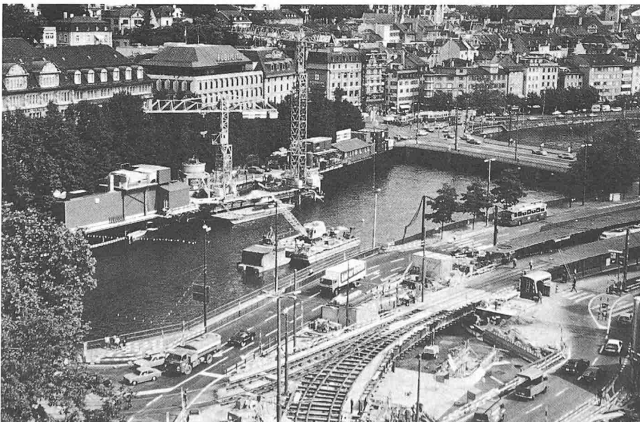
Bild 3. Baustellen am Bahnhofquai und in der Limmat
