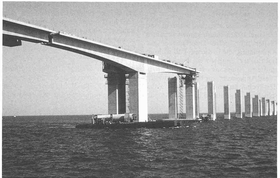
Bild 4. Freivorbaubrücke als Hauptnavigationsöffnung
