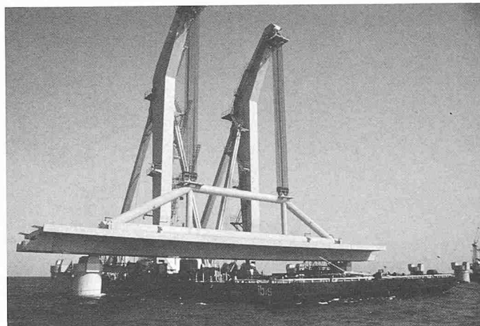
Bild 7. Versetzen eines Standard-Brückenträgers mit Spezial-Hubschiff
