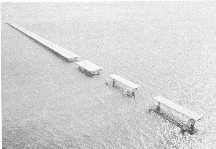
Bild 2. Standardbrücken in verschiedenen Montagestadien
