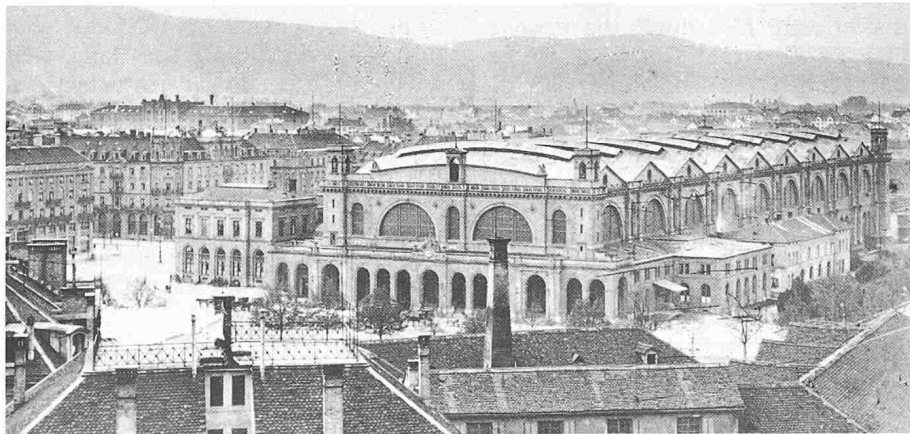
Die zufällig wirkenden Anbauten auf der Nordseite der Halle vor der Jahrhundertwende
