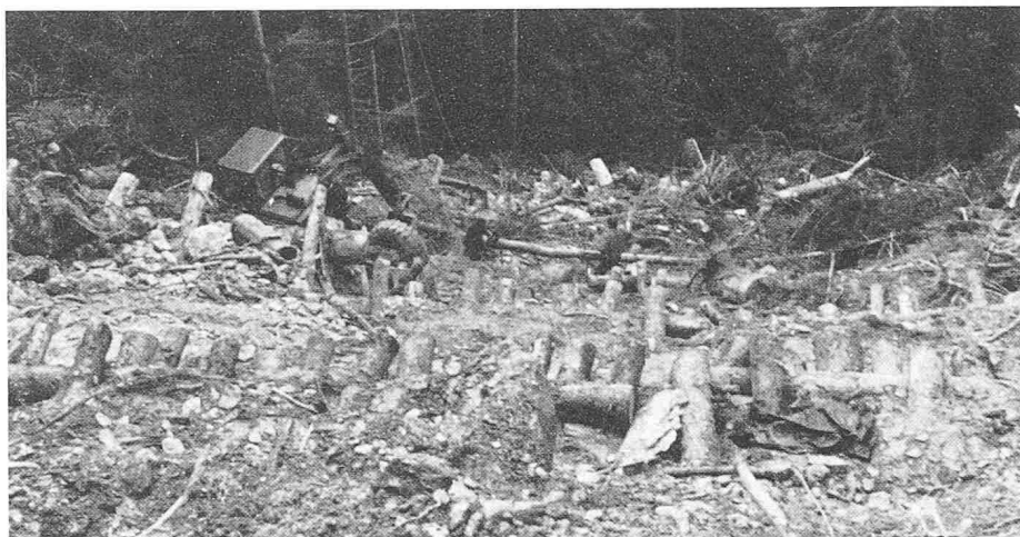
Fig. 2. La largeur des caissons était de quatre mètres pour permettre une bonne manipulation
