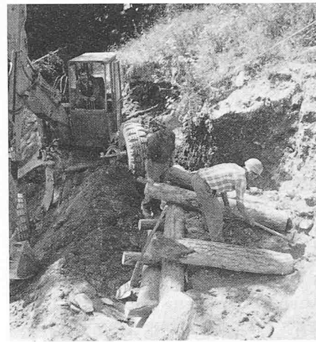
Fig. 3. L'assemblage des bois se faisait à l'aide de clous et les éléments étaient liés entre eux à l'aide de clameaux
