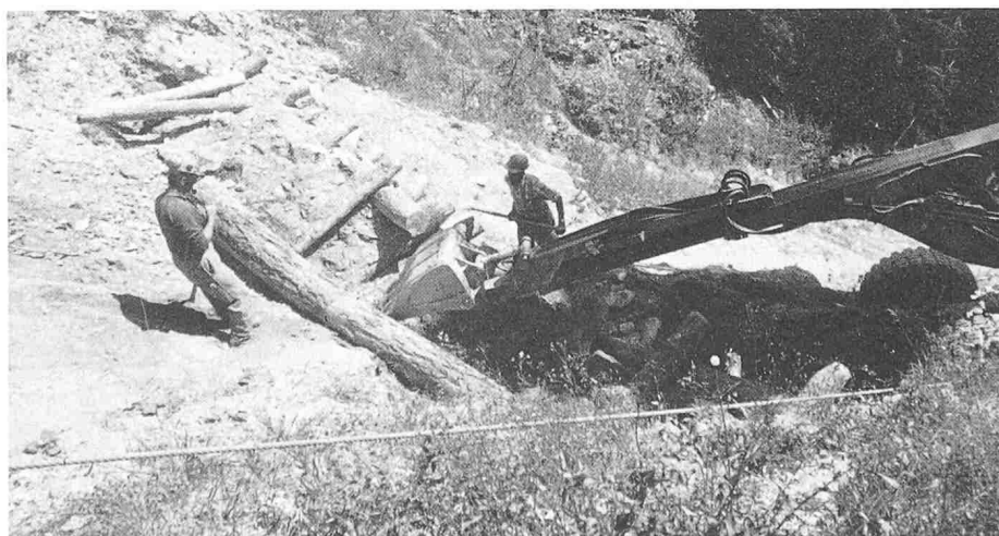
Fig. 4. Remplissage des caissons
