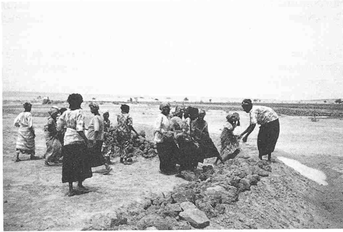
Fig. 3. Keita (Niger, 1985): murs anti-érosifs en construction
