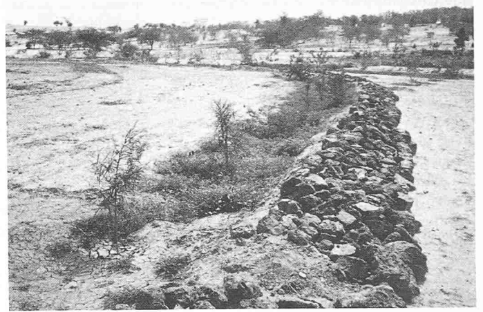
Fig. 4. Keita (Niger, 1985): murs anti-érosifs, plantation (DRS) et enverdissement naturel
