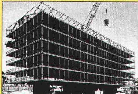
Stahlkonstruktion eines Verwaltungsgebäudes mit an den Dachträgern aufgehängten Zwischenböden
