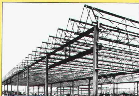
Metallstruktur eines Fabrikgebäudes mit Mini-Sheddach
