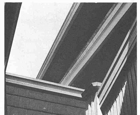
Venustas Wohnhaus und Studio von Frank Lloyd Wright, Oak Park, 1889–95. Durchspielen des Holzmotives von Brett, Schindel bis zur dekorativen Balustrade
