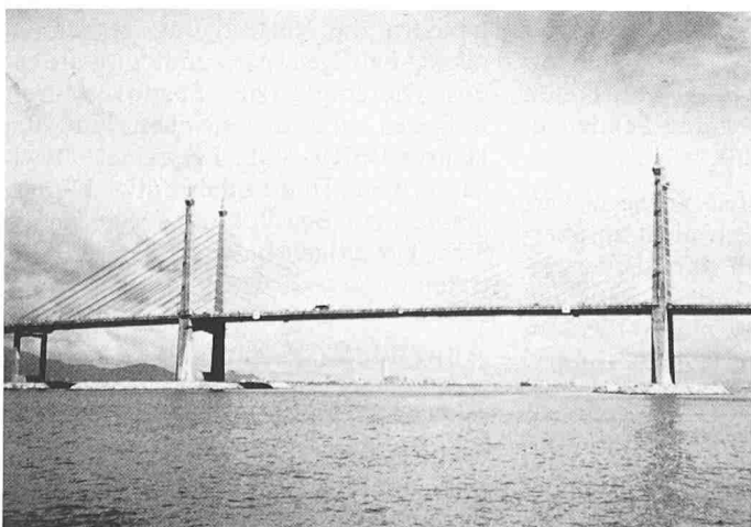
Bild 4. Ansicht der Penang-Brücke (Malaysia)
