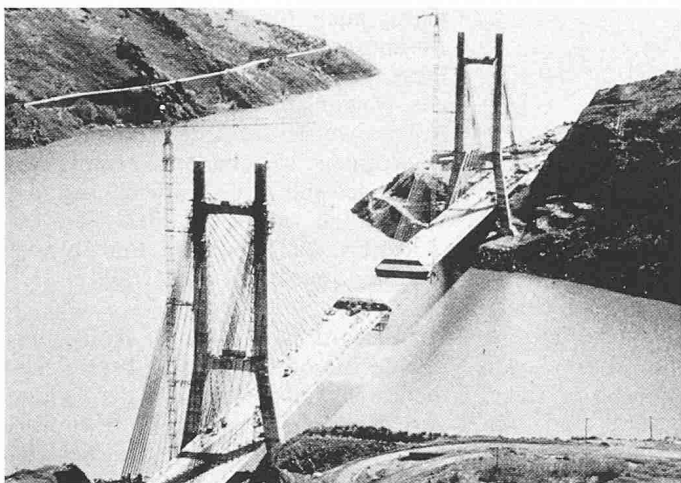
Bild 6. Ansicht der «Barrios de Luna»-Brücke (Spanien)
