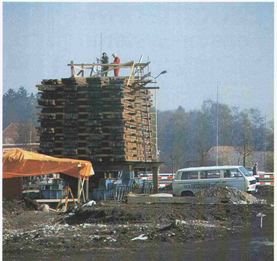
Pfahlbelastungsversuch Viadukt Neugut
