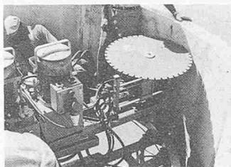
Nach Entfernen des Krangehänges erfolgt der Schnitt und die Unterkeilung des abgesägten Kaminstücks. Dieses wird dann mittels Kran und Tragkreuz abgehoben und die Arbeitsbühne um die gewünschte Teilhöhe nach unten versetzt. Da Hochkamine unten einen grösseren Durchmesser aufweisen als oben, kann man die Plattform rundherum durch Ansetzen von Teilstücken erweitern.
