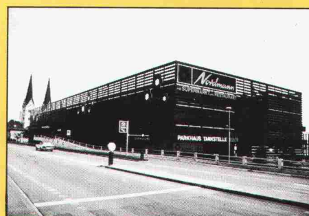
Mehrgeschossiges Parkhaus mit Zufahrt über Rampen
