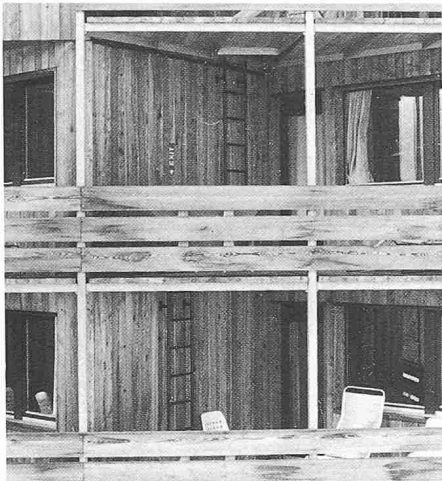
1980, Schulungszentrum mit Hotel und Jugendhaus auf dem Hasliberg BE. Holzkonstruktion mit roher Lärchenschalung um massiven Erschliessungskern.
