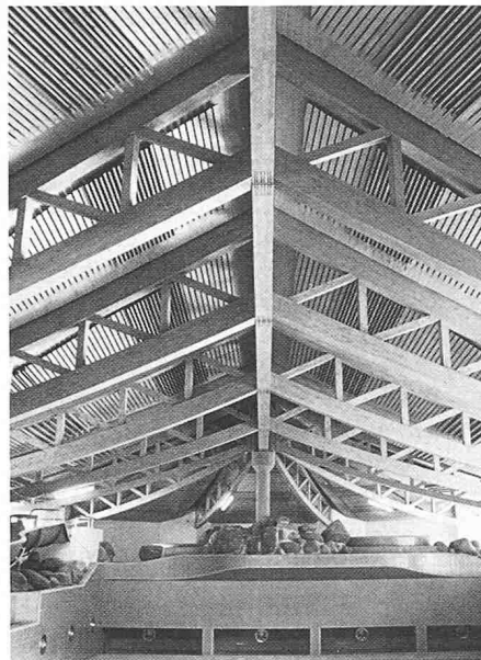
Überdachung des Schwimmbades im neuen Freizeitzentrum Abtwil SG
