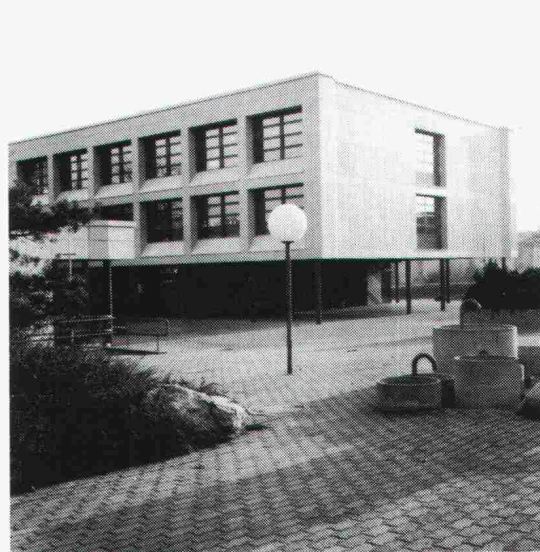
Schulhaus Bülach Struktur Sichtbeton
