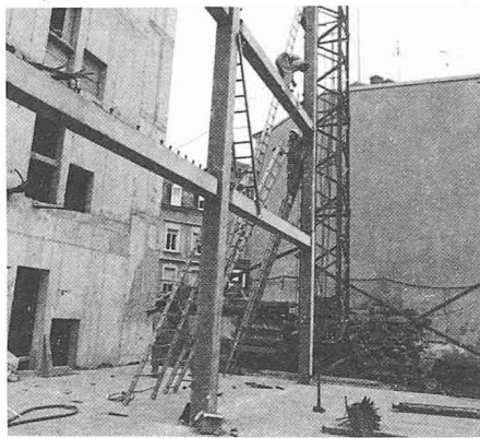
Bild 6. Dachstuhl in Stahlbauweise
