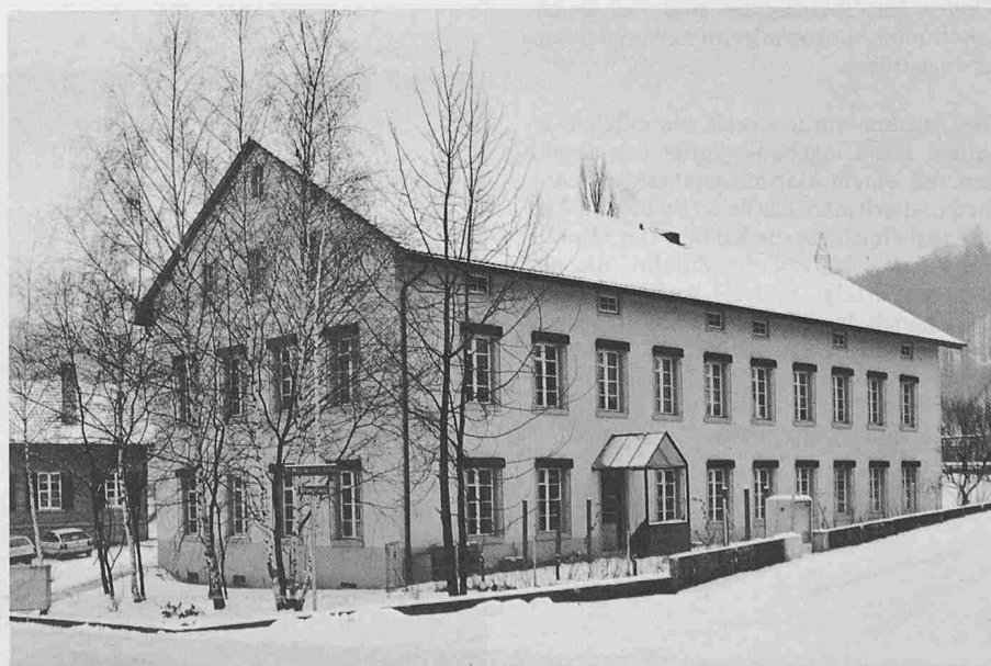
Westansicht, Zugang Gemüsegarten
