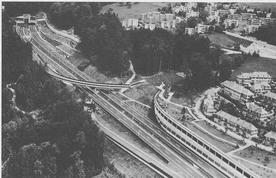
Einfahrt zum Westportal des knapp 1500 m langen Rosenberg隧nells (hinten links). Im Vordergrund (rechts) zweigt der Schorentunnel zum innerstädtischen Anschluss Kreuzbleiche ab
